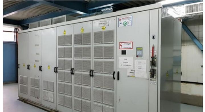
Высоковольтный частотно-регулируемый привод
