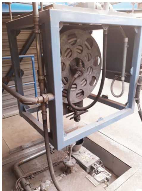
Рис. 14. Элементы системы водяной обмывки и устройства для ее ввода в газовый тракт котла
